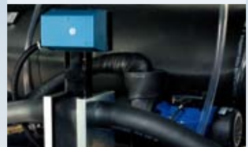
3-Wege-Wasserventil mit Stellantrieb.
