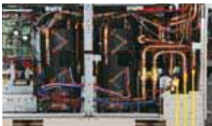
Flüssigkeitsseite Gasansaugung Gasvorlauf
